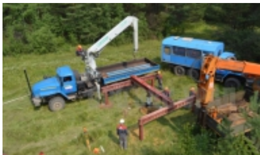
Полевые испытания грунтов сваями
